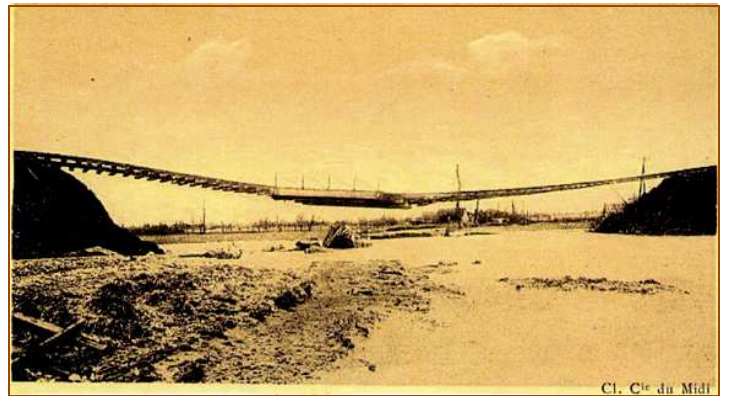
Fig.4: La voie ferrée entre Montauban et Moissac
