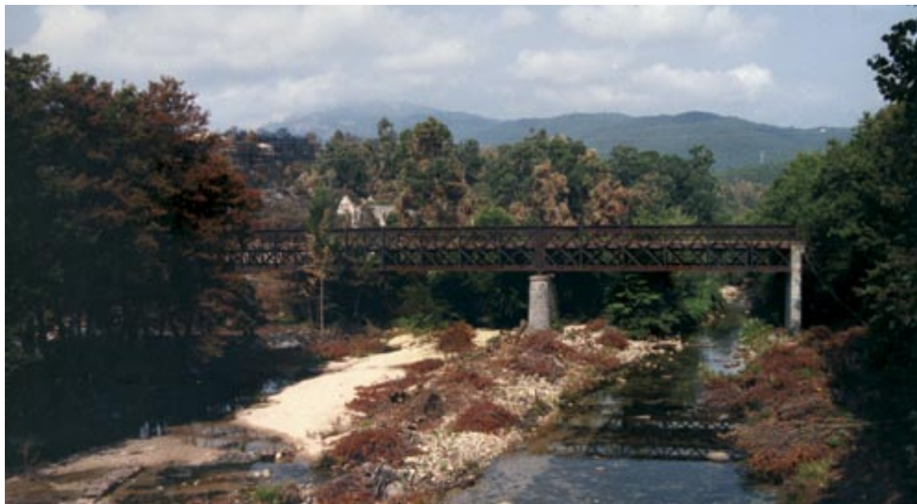
Le pont de chemin de fer sur la Solenzara avant la crue.
