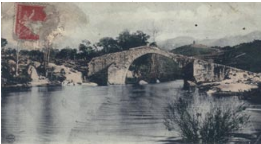
Pont génois Spiu à Cavallu après la crue du 9 novembre 1892.
