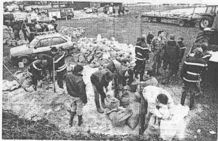
Dimanche midi, à Saint-Hilaire Petitville, aux portes de Carentan (Manche), pompiers et bénévoles remplissent des sacs de sable pour relever la digue et tenter d'empêcher l'eau de continuer à envahir le supermarché Leclerc.
